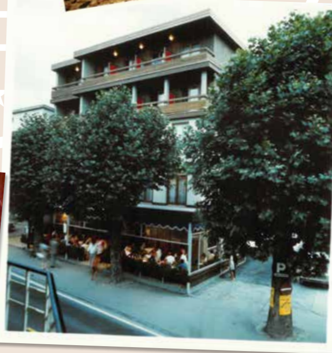
1968/1969 wurde wieder kräftig investiert und das Stammhaus um einen dritten und einen vierten Stock erweitert. Die Wiedereröffnung war zu Saisonbeginn 1969.
