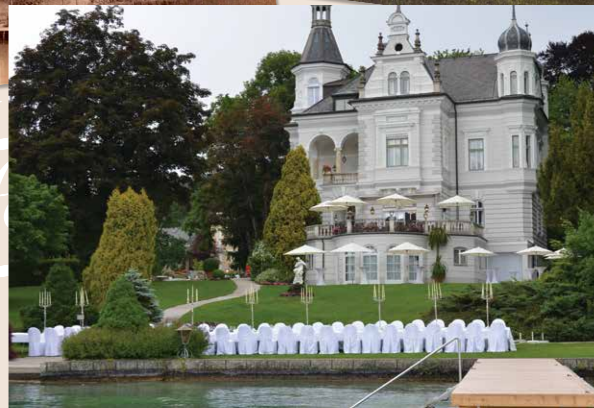
Die neu angebaute Terrasse der Parkvilla Wörth schmiegt sich perfekt an das historische Gemäuer und wird zum Lieblingsplatz vieler Urlauber.
